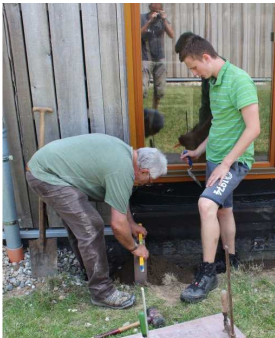
Abb. 2: Arbeiten an den Fensterstufen am Haus der Artenvielfalt.
